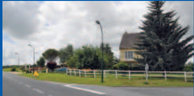
Effacement des réseaux du hameau de Villepatour
