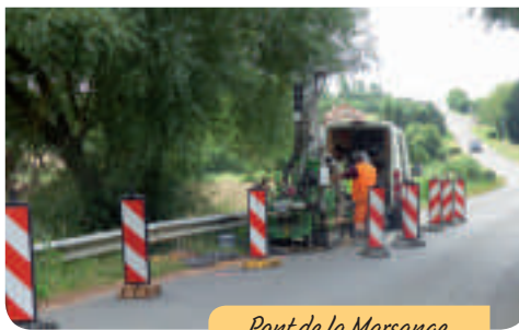
Pont de la Marsange
