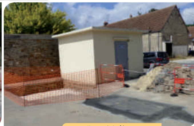
Installation de la fibre optique
